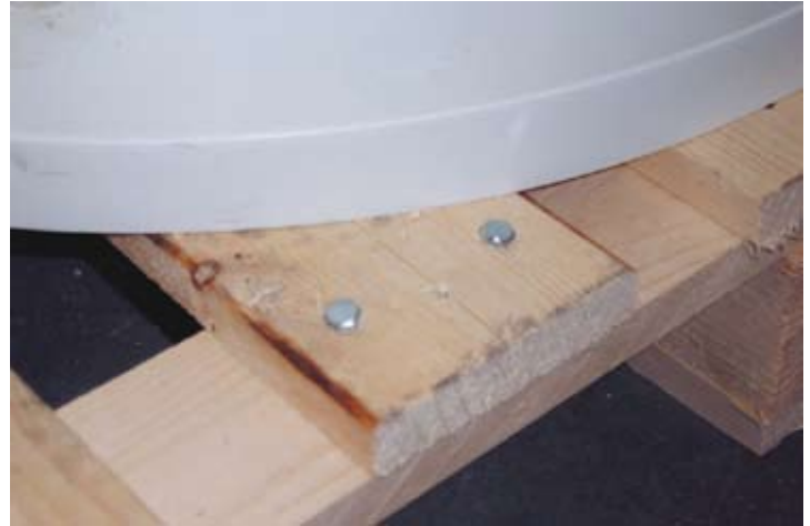
1. Skruer, der skal fjernes (sekskantet hoved).
